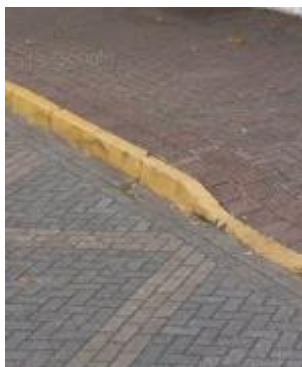
Figura 6 - Meios-fios funcionando para drenagem e delimitadores de pavimento.
